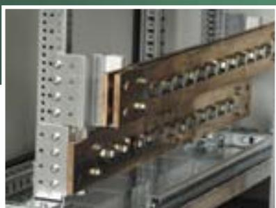
Оптимальное расположение нулевого рабочего проводника и проводника защитного заземления на профиле шкафа. Нулевой проводник имеет то же сечение, что и внешние рабочие проводники.
