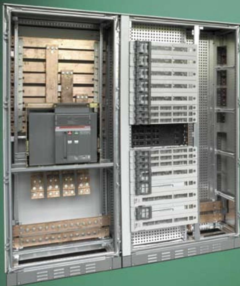
Новая электрическая распределительная система, рассчитанная на большие токи, была создана на основе успешно зарекомендовавшей себя на рынке системы распределительных шкафов TriLine-R и предназначена для установки в жилых домах, а также производственных, торговых и административных зданиях.
