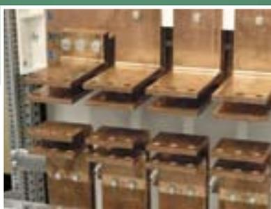
Система соединения шин позволяет использовать автоматический выключатель на 4000 А с 3 и 4 полюсами, фиксированного крепления или выкатной.
